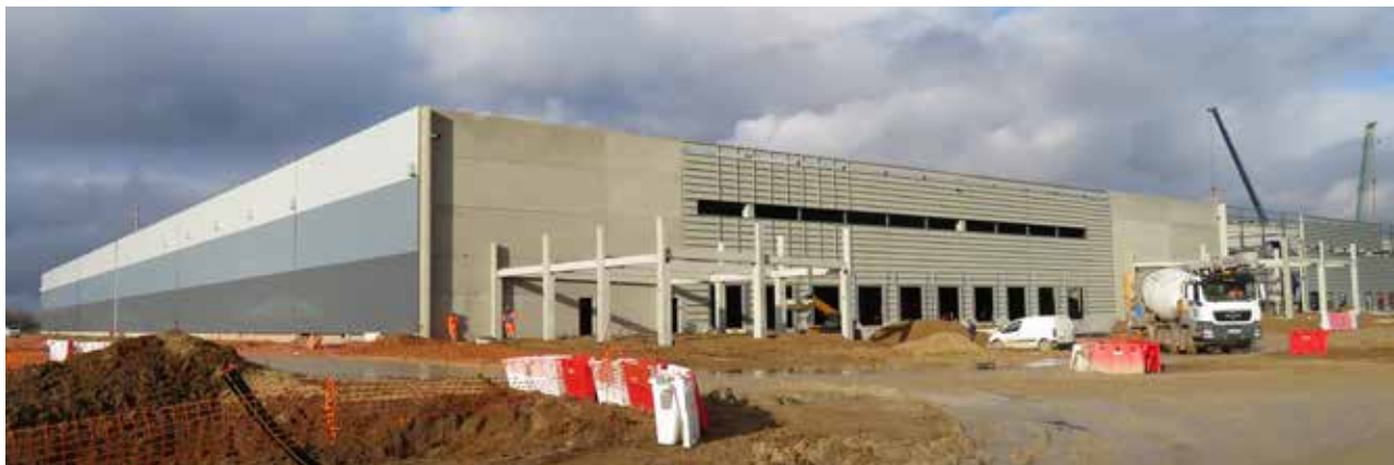
Entrepôts de logistique Mountpark en cours de construction sur le Parc d'Activités Synergie Val de Loire
